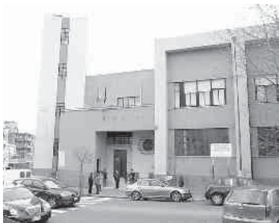
La sede del Tar di Reggio Calabria
